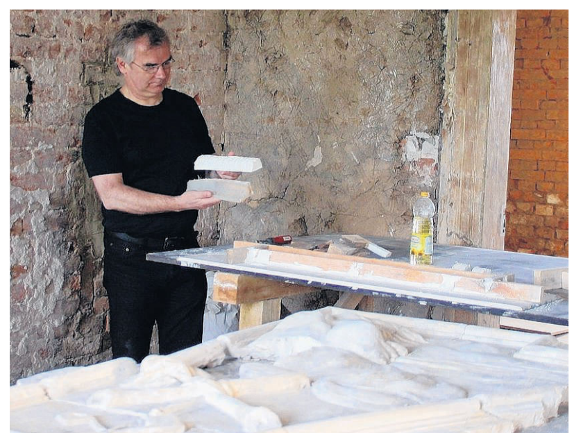
Die Stuckarbeiten gehen voran, wie Volker Riedel zeigt.
